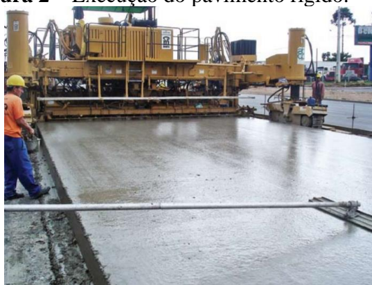
Figura 2 – Execução do pavimento rígido.
